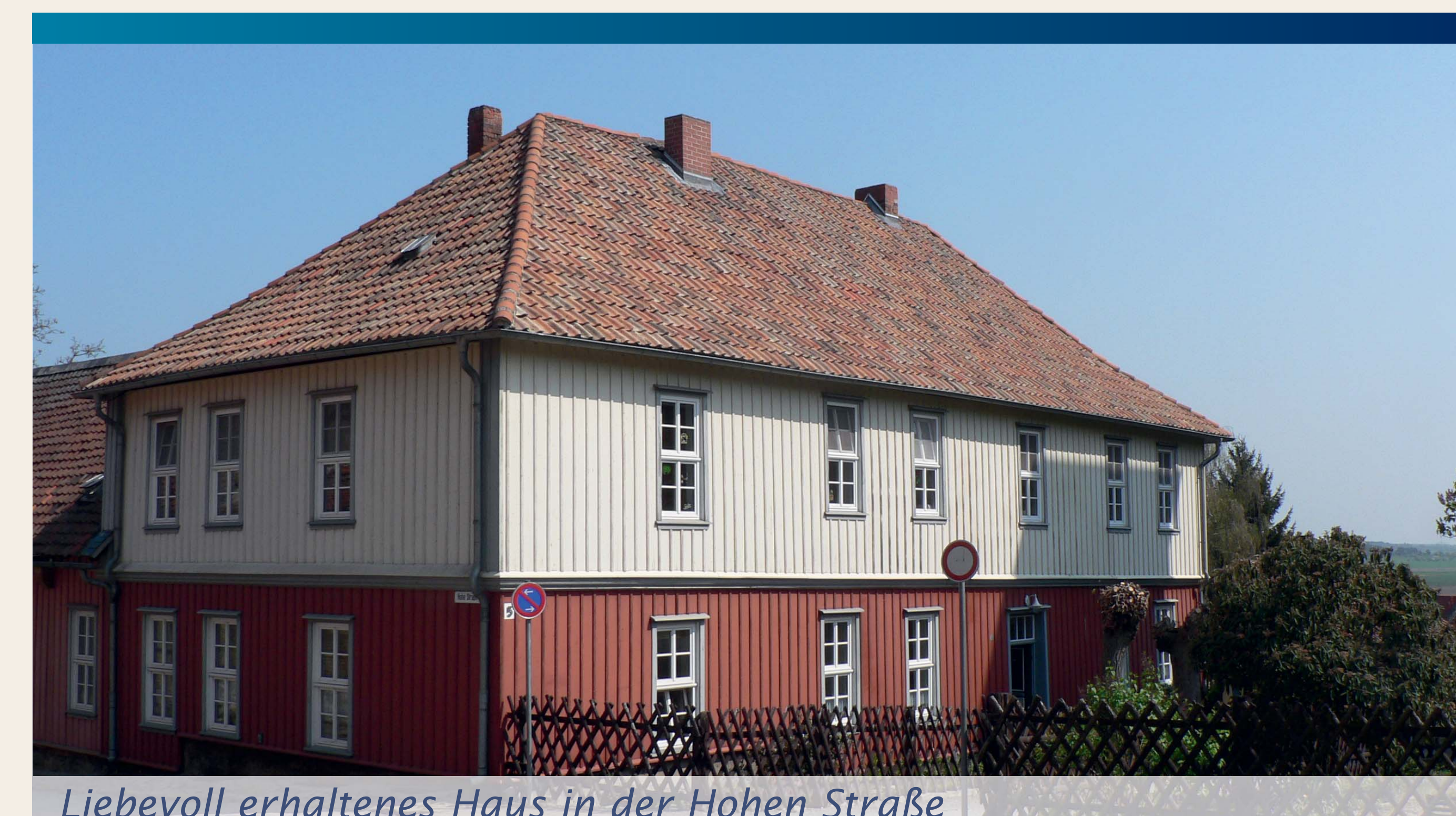
Liebevoll erhaltenes Haus in der Hohen Straße
