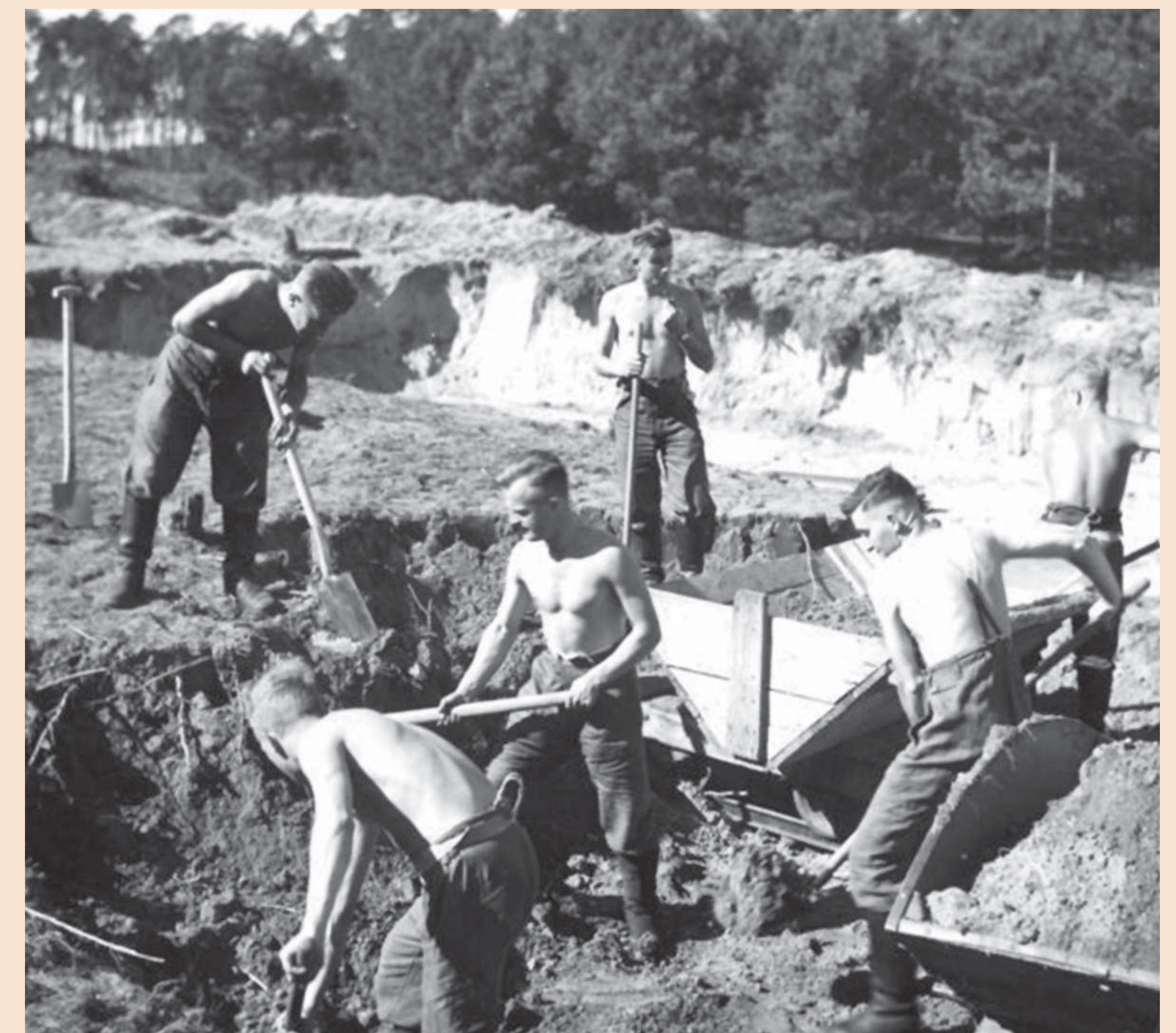
Arbeitsmänner beim Straßenbau
